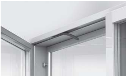
Suodattimien vaihto avattavassa ikkunassa.
